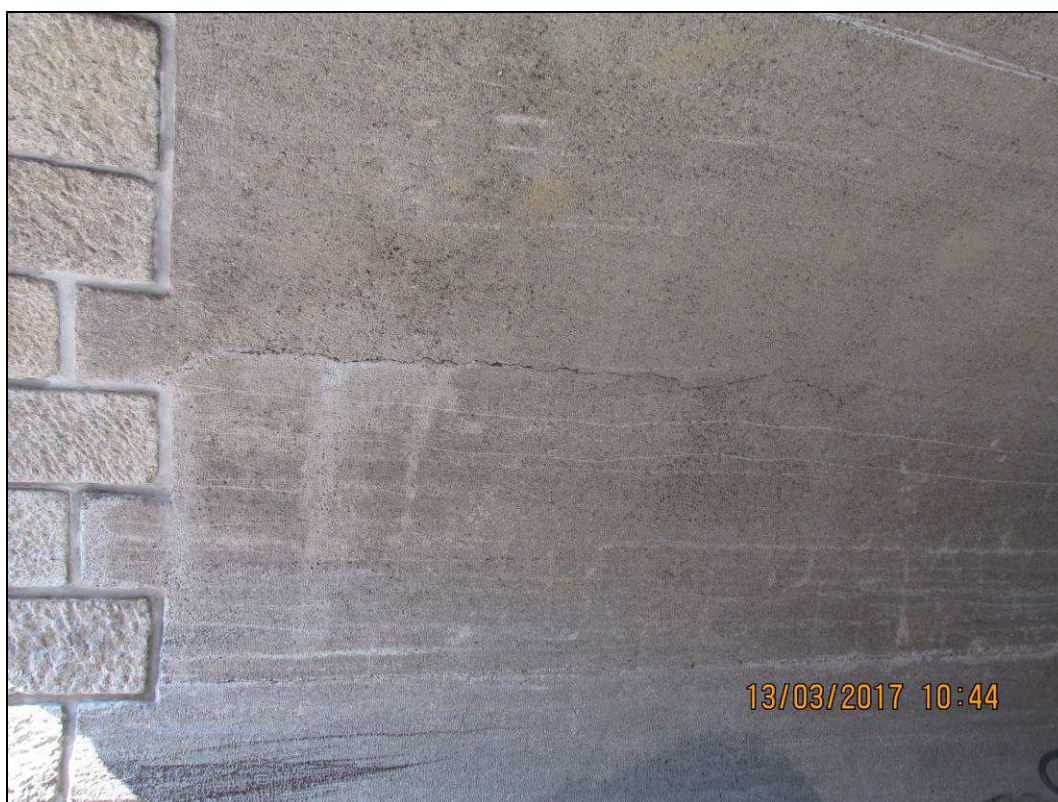
Obr. č. 6 - podélná vlasová trhlina - levá část objektu směrem Kuřim
